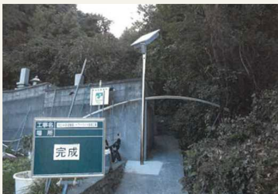
街灯設置工事
