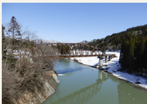
(2) 復旧後の第7只見川橋りょう
