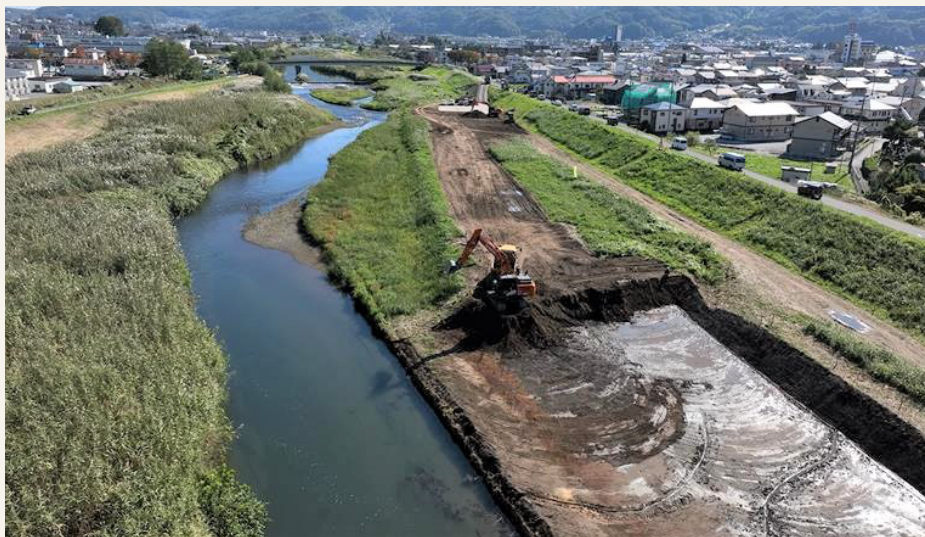
河道拡幅・掘削
