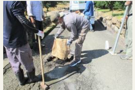
農道補修作業
